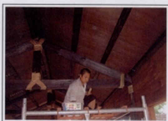
閒置空間—水電管路建置
