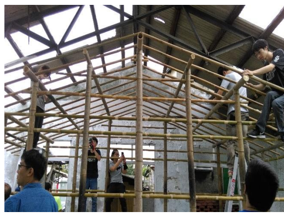
強化屋頂結構與進行牆面竹栓程序
