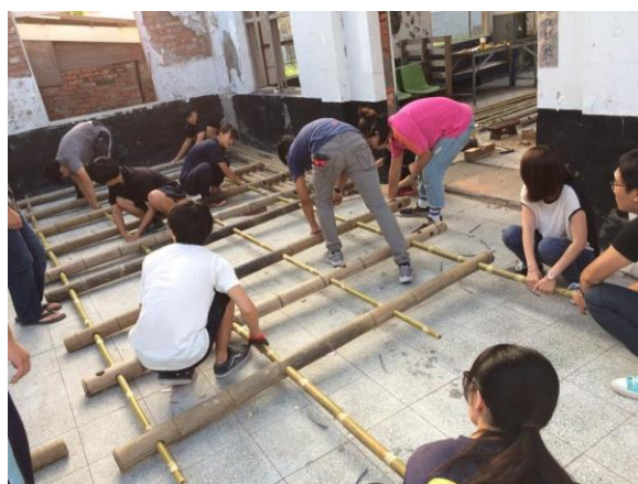
利用木槌與丸形鑿刀將牆面結構榫接
