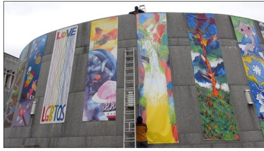
懸掛帆布施工
