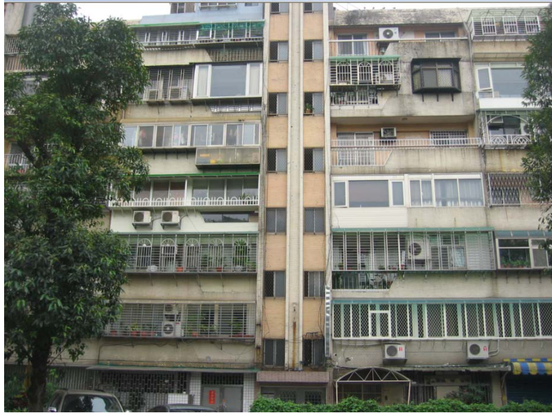
圖：公園附近房屋皆為老舊住宅，急需都市更新。
