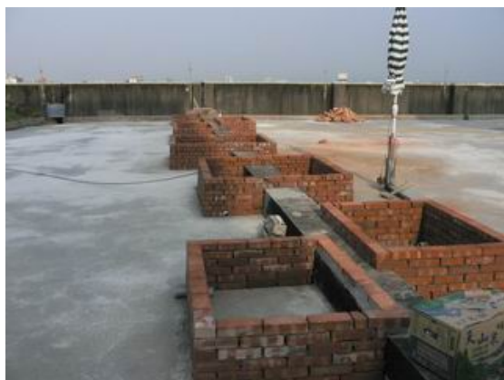
砌磚施工過程
