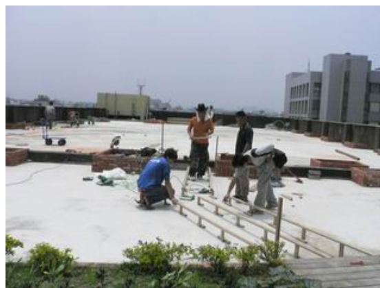
木棧道架設施工過程
