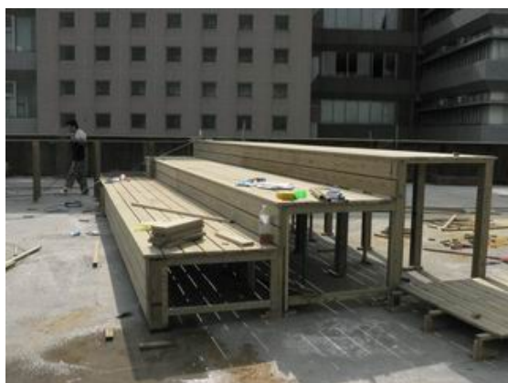
教學平台施工過程
