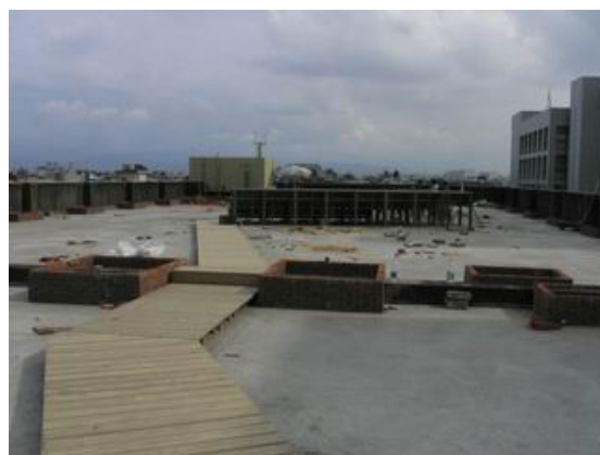
木棧道架設施工完成
