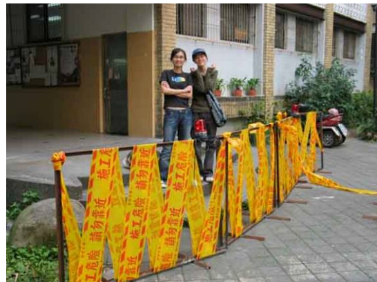
終於完作施工圍籬施作
