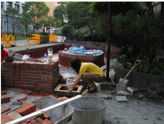
水溝蓋工程施作
