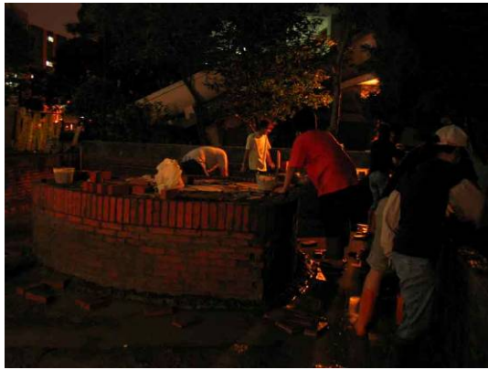
砌磚工程施作
