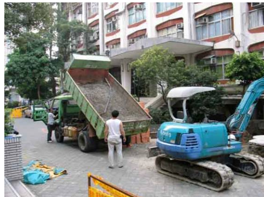
怪手進行基地底部鋪砂工程
