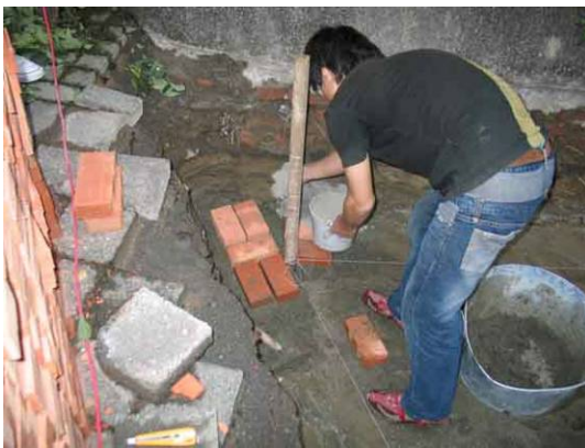
第一皮 PC 打底砌磚施作
