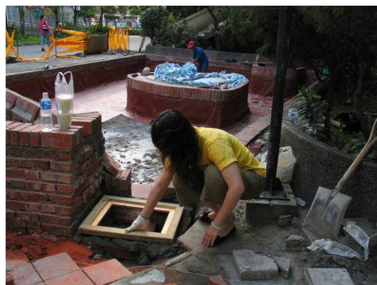
防水層工程施作
