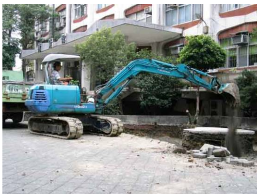
怪手進行基地底部鋪砂工程
