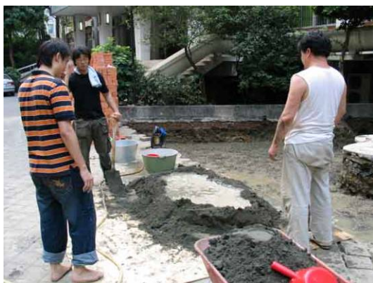
人工拌混凝土
