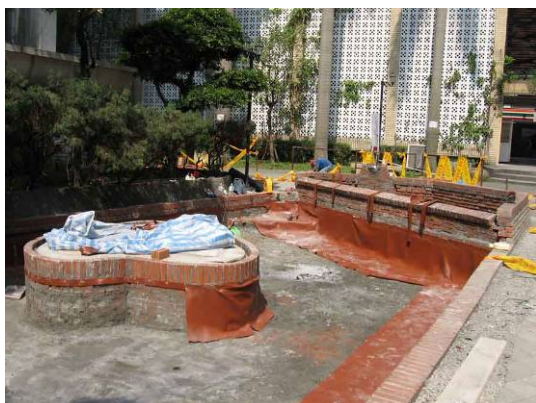
防水層工程施作
