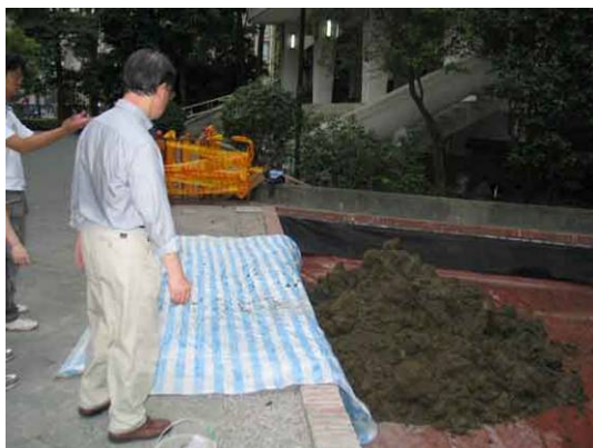
進土作業工程
