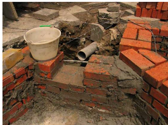
預留排水溝施工&趕工
