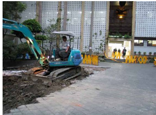
怪手開挖施工
