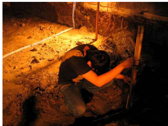
第一皮砌磚施作
