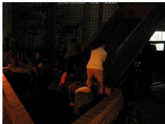
進土作業工程
