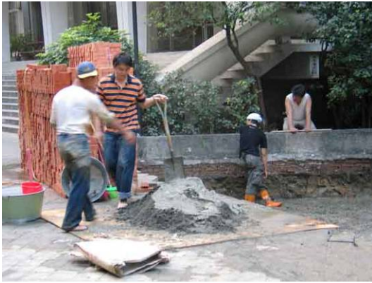
人工拌混凝土
