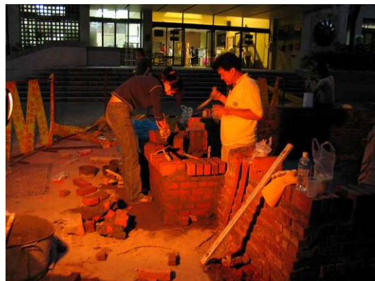
出水口重新施作
