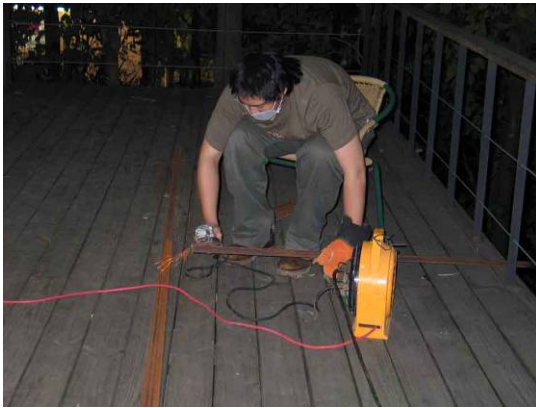
施工圍籬框架由學生親自動手焊接
