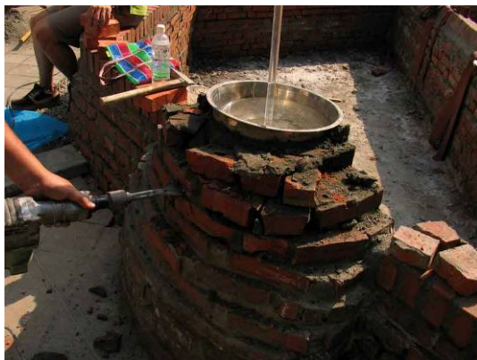
出水口敲除工程
