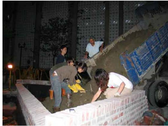
進土作業工程
