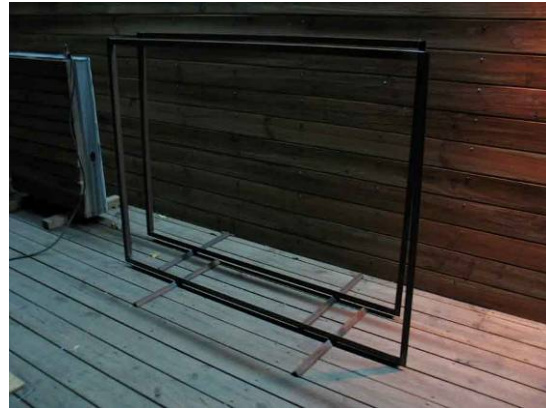
完成之施工圍籬框架
