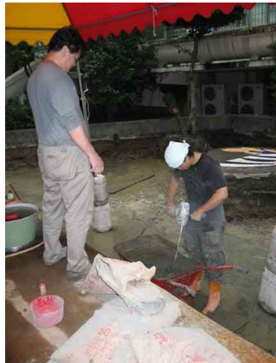
由專業廠商協助指導操作手動式混凝土攪拌機之 PC 攪拌
