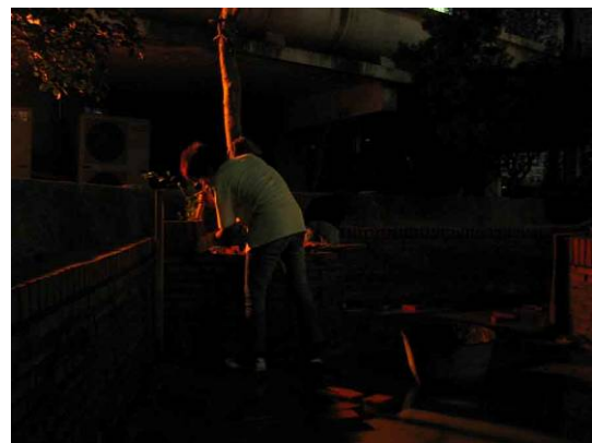
砌磚工程施作
