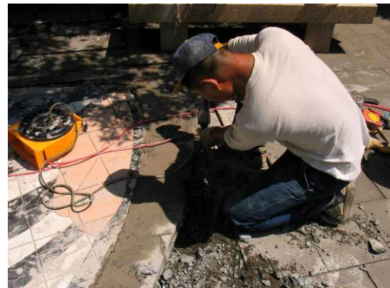
專業廠商施作蝴蝶保留區域邊界切割 手動電鑽怪手震碎硬鋪面
