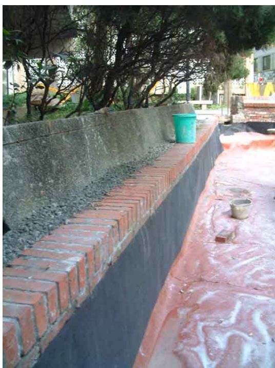
防水層工程施作
