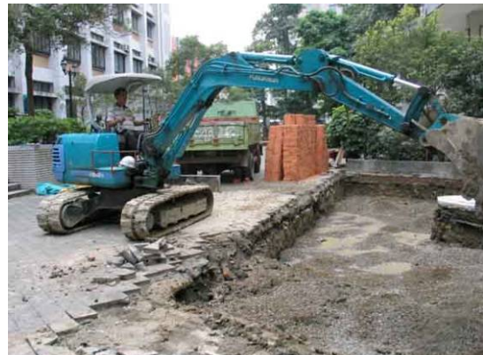
怪手進行基地底部鋪砂工程
