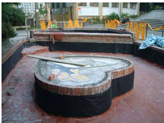
防水層工程施作
