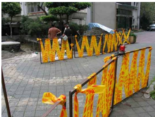
完成之施工圍籬
