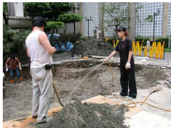
人工拌混凝土
