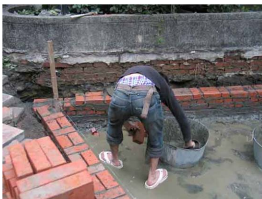
砌磚工程施作
