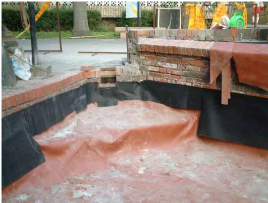
防水層工程施作
