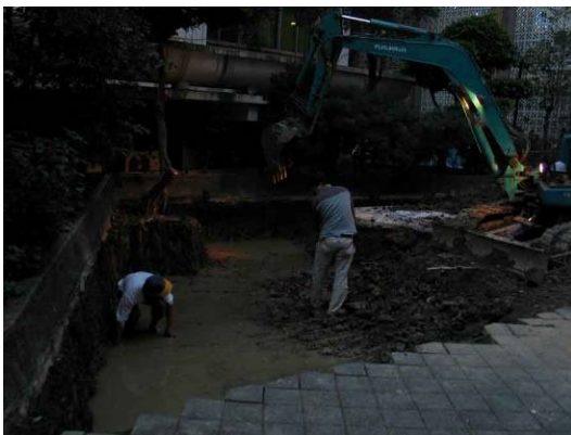
怪手開挖施工
