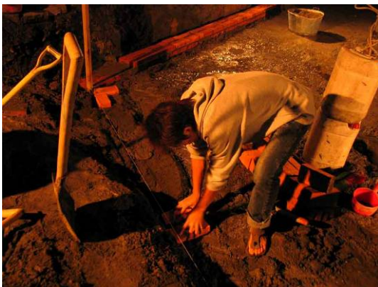
第一皮砌磚施作
