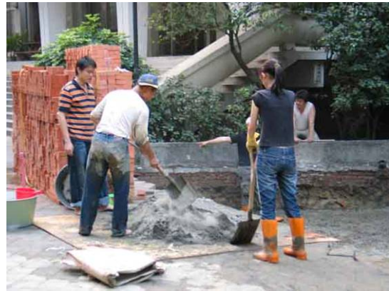
人工拌混凝土
