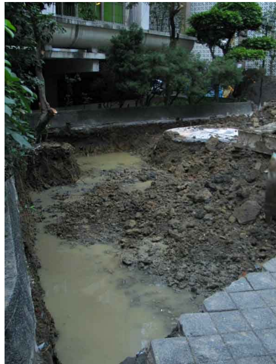
開挖時透水鋪面水滲入基地
