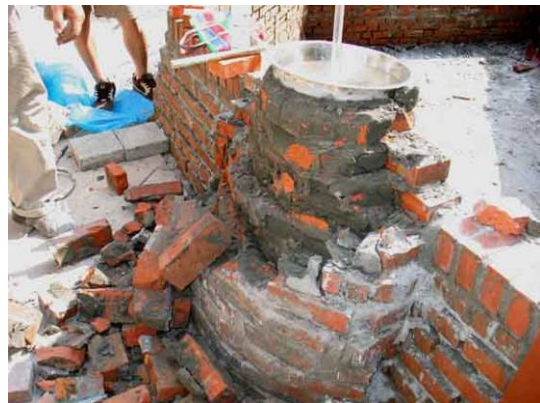
出水口敲除工程
