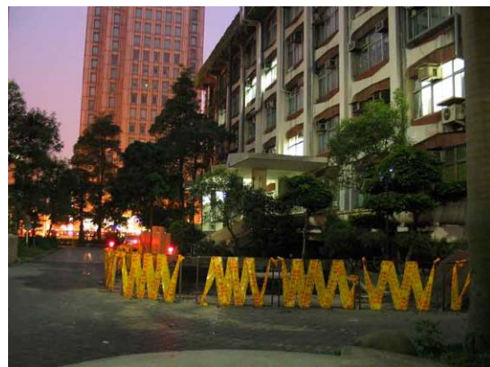
施工圍籬安置於基地範圍
