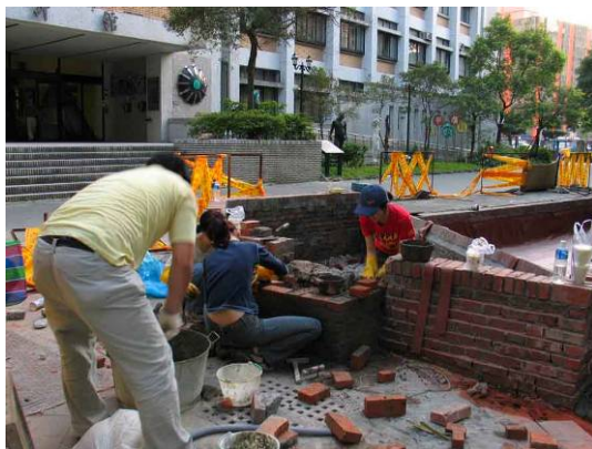
出水口重新施作
