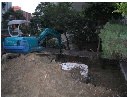
怪手開挖施工
