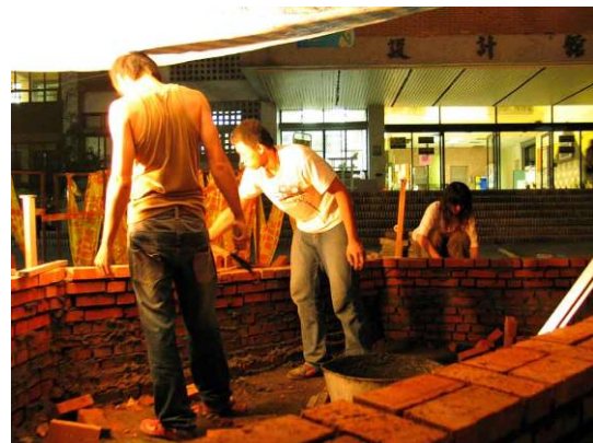
砌磚工程施作
