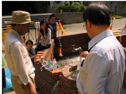
砌磚工程施作
