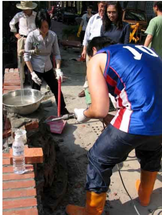
出水口敲除工程
