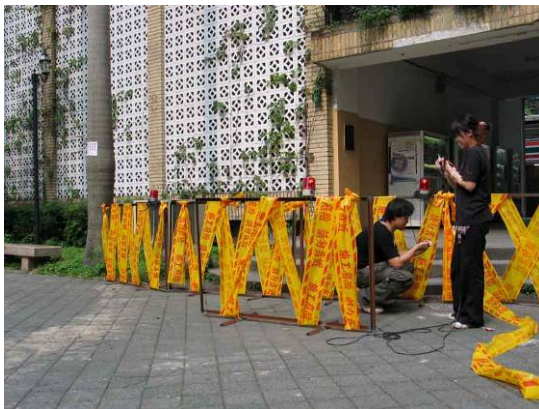
施作中的施工圍籬
