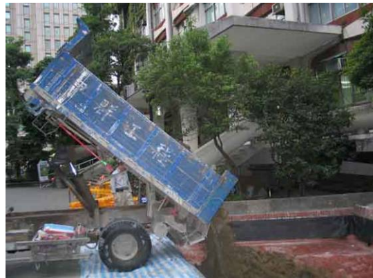
進土作業工程
