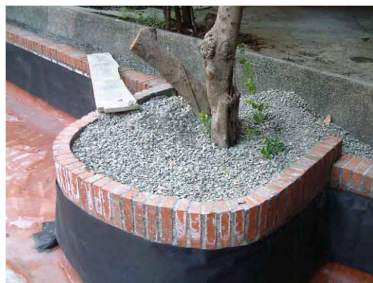
防水層工程施作
