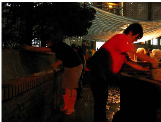
砌磚工程施作
