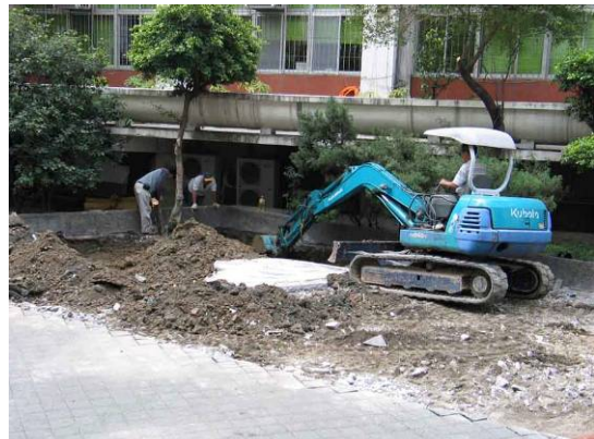
怪手開挖施工
