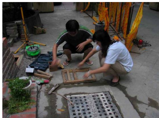
水溝蓋工程施作
