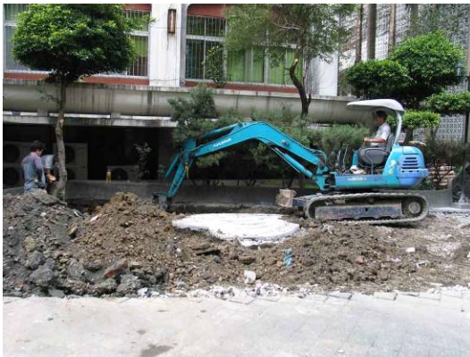
怪手開挖施工
