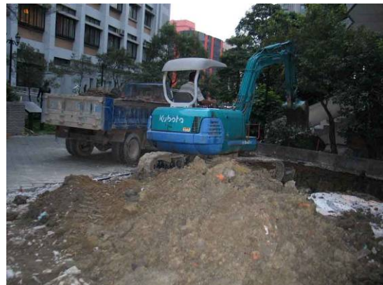
怪手開挖施工
