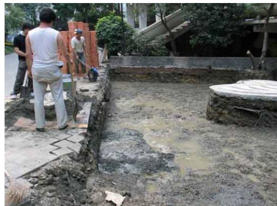
人工拌混凝土
