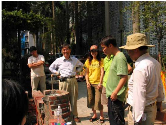
出水口敲除工程
