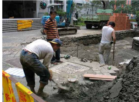
人工修復(電纜由廠商施作)
