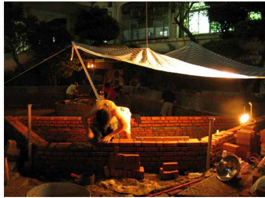
砌磚工程施作
