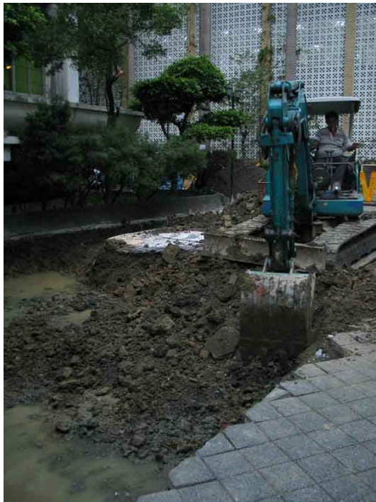
怪手開挖施工
