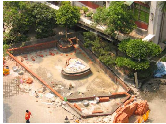
砌磚工程施作
