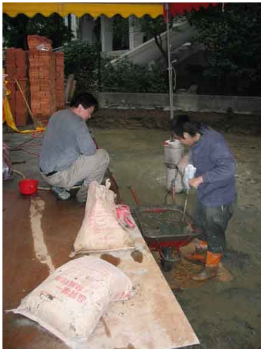
由專業廠商協助指導操作手動式混凝土攪拌機之 PC 攪拌
