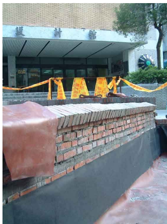
防水層工程施作
