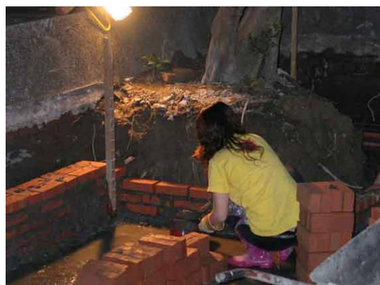
砌磚工程施作
