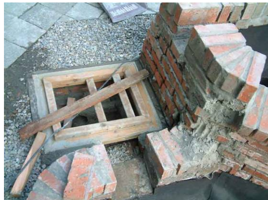
水溝蓋工程施作
