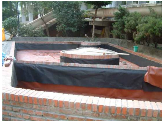
防水層工程施作
