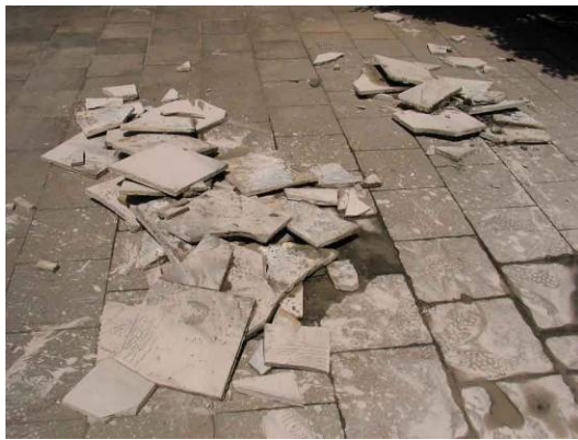
原觀音山石硬鋪面移除
