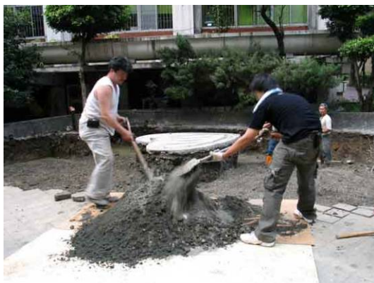
人工拌混凝土
