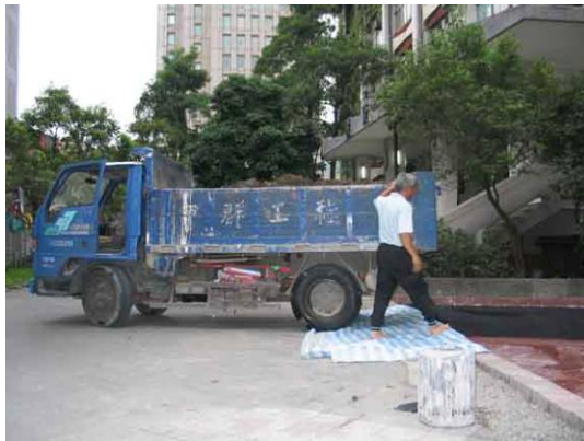
進土作業工程
