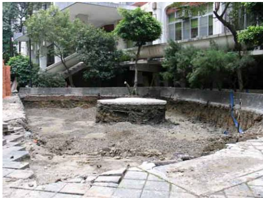
怪手進行基地底部鋪砂工程
