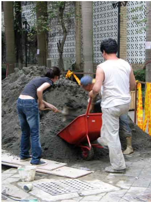
人工拌混凝土
