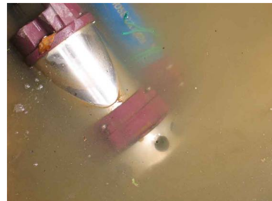
以沈水式抽水馬達抽水
