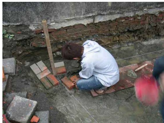
第一皮砌磚施作
