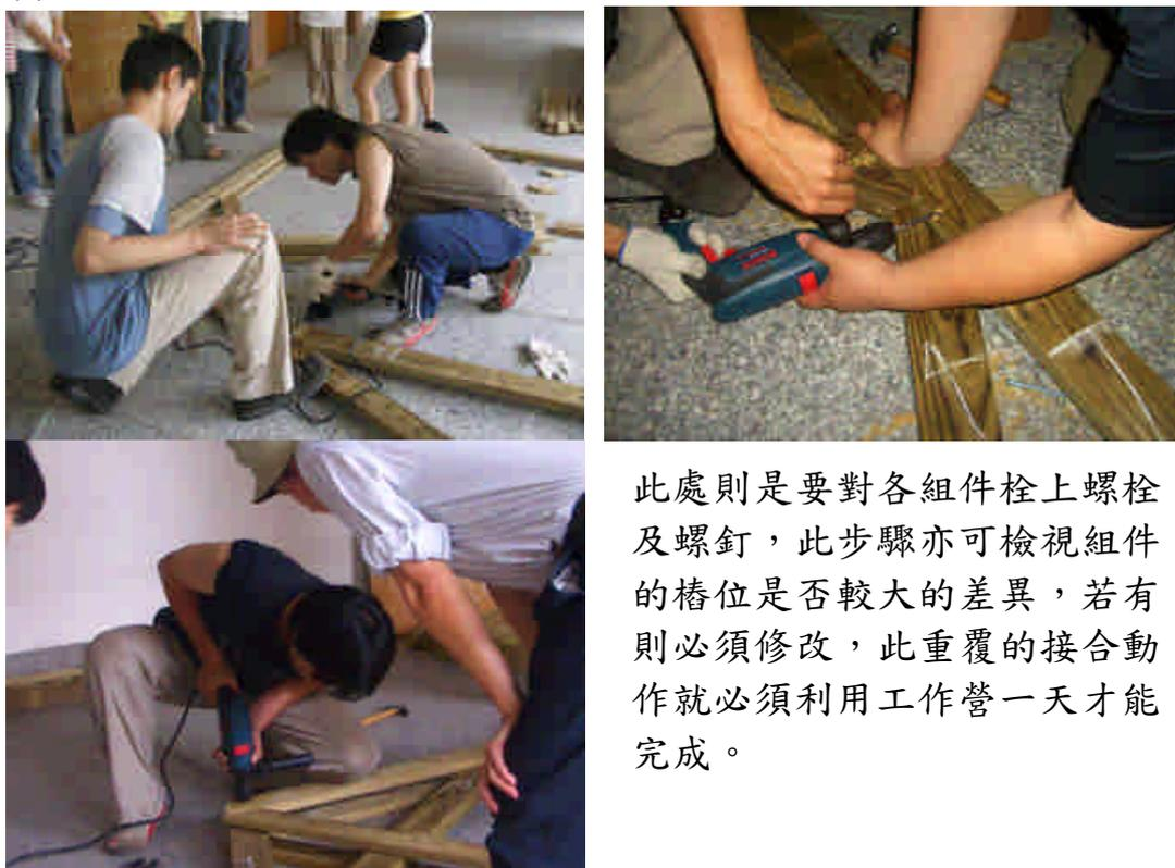
此處則是要對各組件栓上螺栓及螺釘，此步驟亦可檢視組件的樁位是否較大的差異，若有則必須修改，此重覆的接合動作就必須利用工作營一天才能完成。
