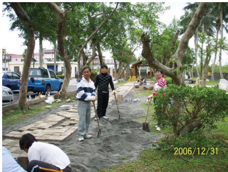
施工照片與經驗分享：(施工中二)
