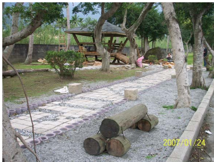
施工照片與經驗分享：(完工照片三)
