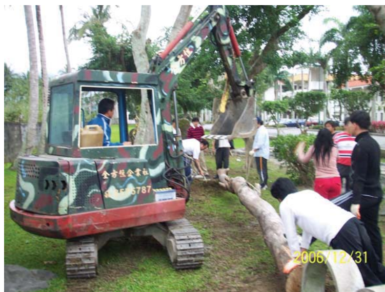
施工照片與經驗分享：(完工照片一)
