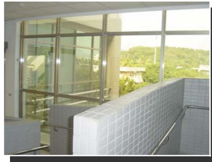
圖書館總館 4F 與副館視聽 C 室間之通道
