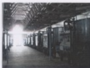
山上鄉淨水廠淨水場的取水口位於曾文溪
