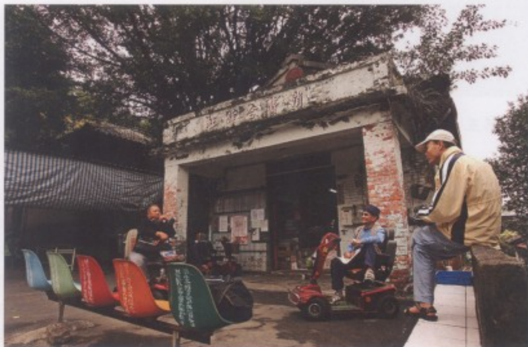
圖 13 樂生療養院面臨拆除的院區
