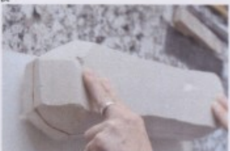
圖六十四： 塗刷混了色粉後的環氧樹脂液。
