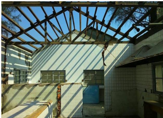
圖 14 「旗津灶咖」屋頂翻修改造
