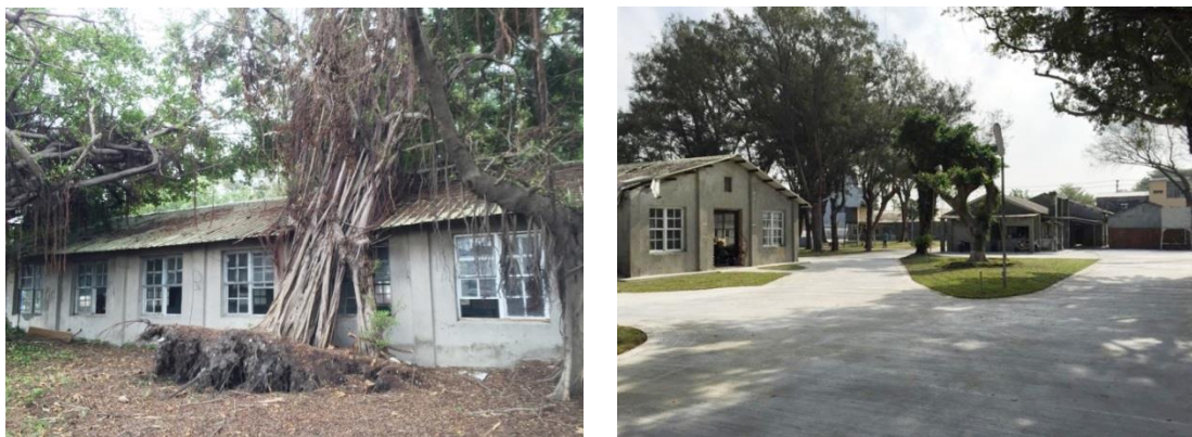
圖 20 改造前與改造後
