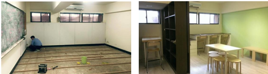
圖 18 改造前與改造後
