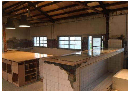
圖 15 「旗津灶咖」內部翻修改造
