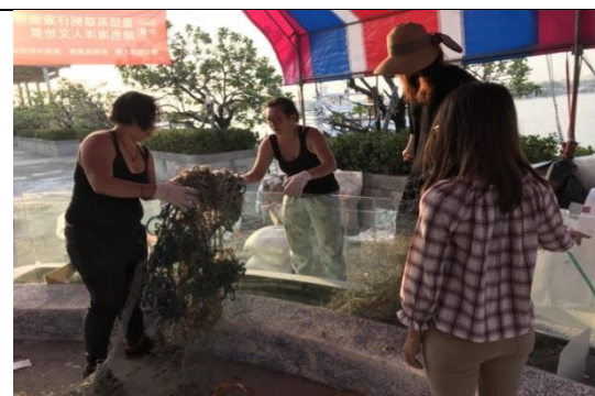
互動裝置藝術「樂塞牆」施工
