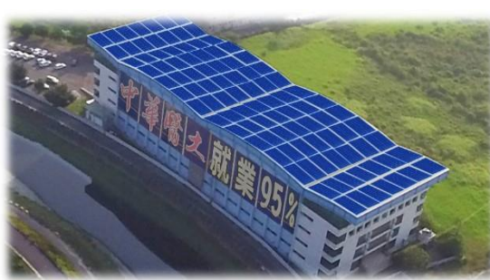
圖 6.體育二館之太陽能發電屋頂
