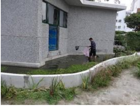
校長承辦新建游泳池 規劃中水池讓水資源循環再利用
