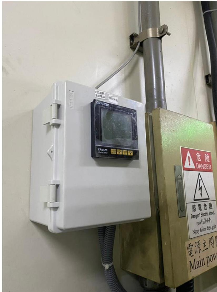
圖 1-11 智慧電錶用防水開關箱設置示意圖
