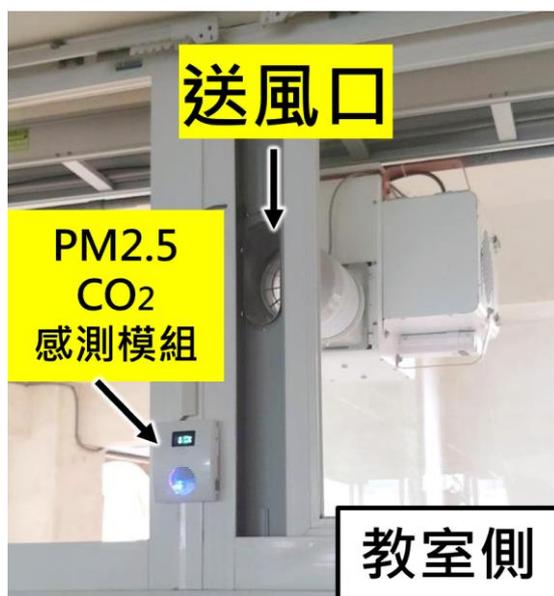
圖 1-13 智慧新風換氣系統安裝原則(教室側)示意圖
