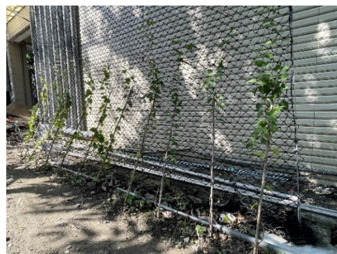
樓面炮仗花垂直綠化，達遮陽降溫效用
