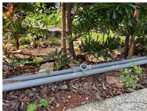
植栽區設置自動灑水管路
