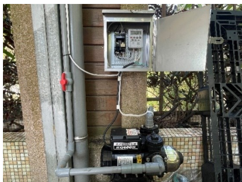
綠籬設置自動澆灌系統-定時器、加壓馬達
