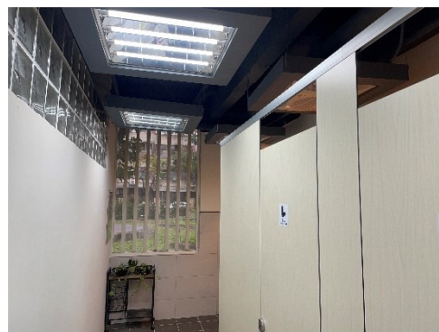
建築角落對外窗加大，增加透氣採光
