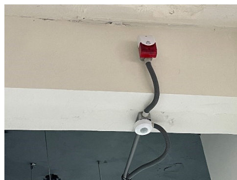
燈具使用增設點滅系統
