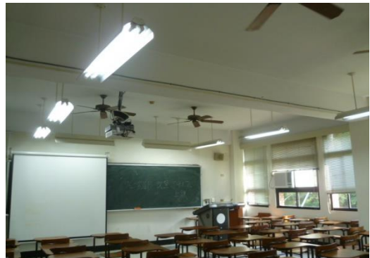
管理大樓教室照明燈更換LED燈具圖
