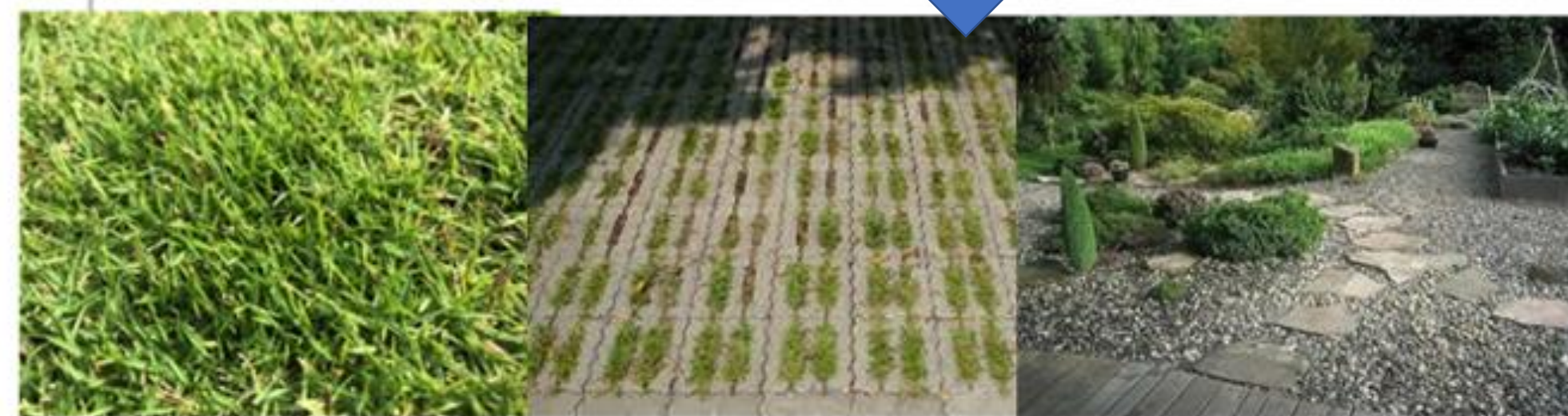
原有硬鋪面更換為透水鋪面
