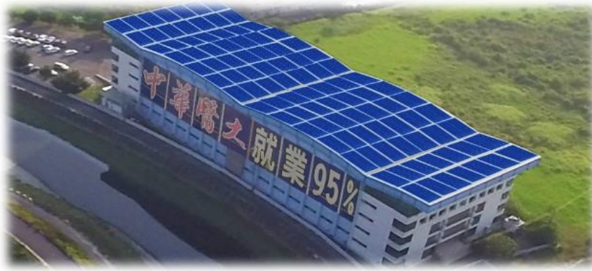
圖2 體育二館之太陽能發電屋頂(明確呼應聯合國永續發展指標 SDG7可負擔的潔淨能源)
