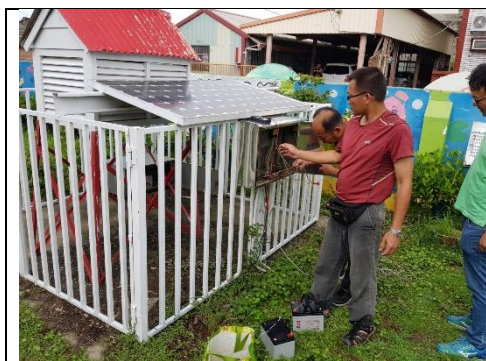
更換蓄電池與電源轉換器
