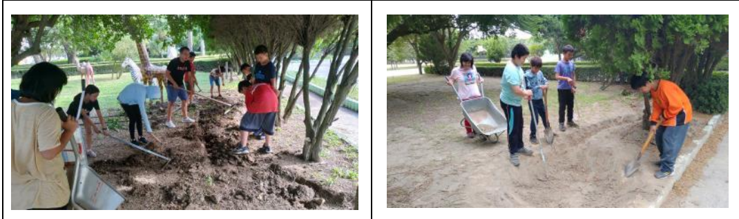
積水區域路緣石鑿穿及陪水渠道挖設
