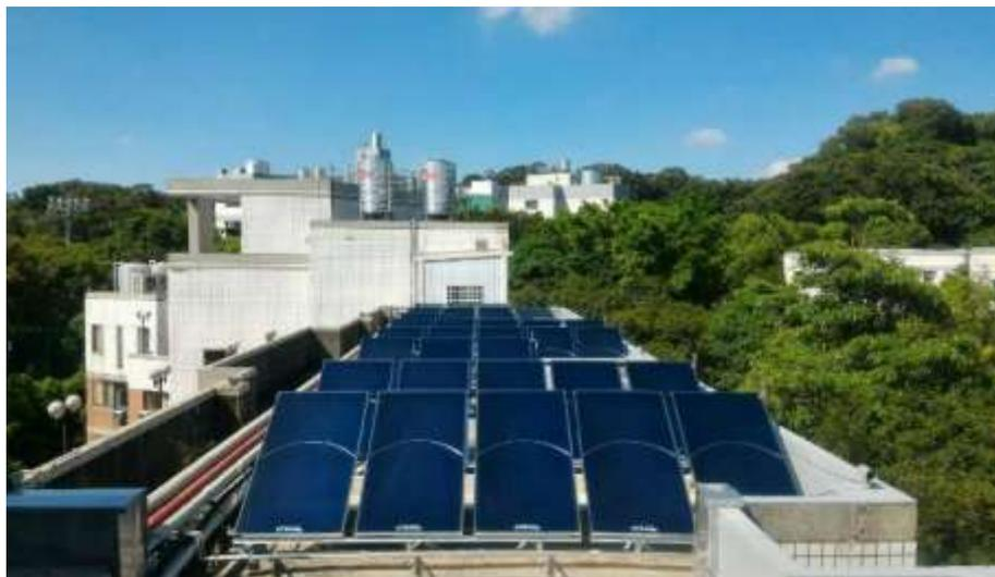
圖 34.宿舍太陽能熱水系統
