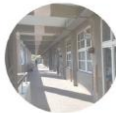
中棟 南向教室外部走廊3.4米深， 樓高3.45米，僅春秋分及冬 季時太陽會深入室內。
