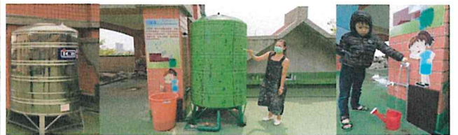
106年水利局補助設置，利用回收雨水，供日光農場澆灌植物用。
