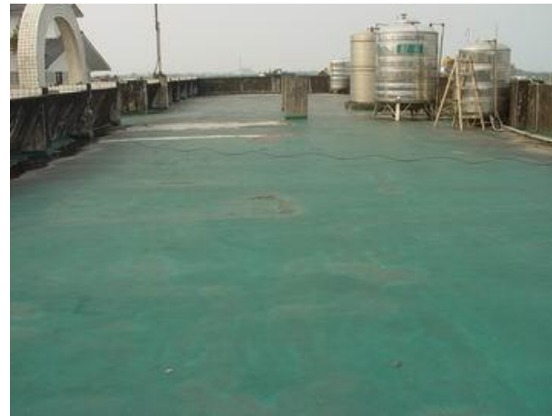
F / 屋頂改善防水及隔熱
