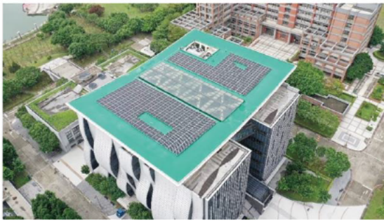
三峽校區圖書館(左)及綜合體育館(右)屋頂上設置太陽能光電板
