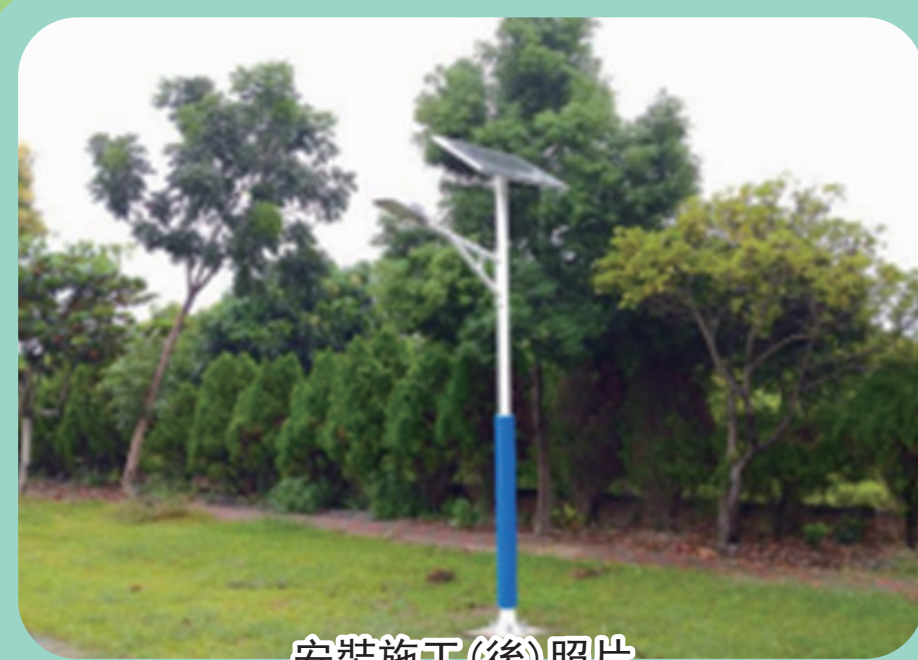
安裝施工(後)照片
