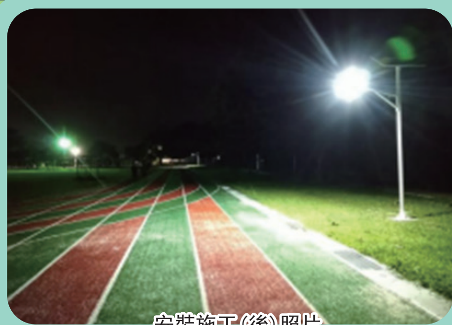
安裝施工(後)照片
