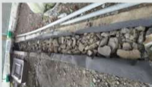
107永續局部改造工程項目
