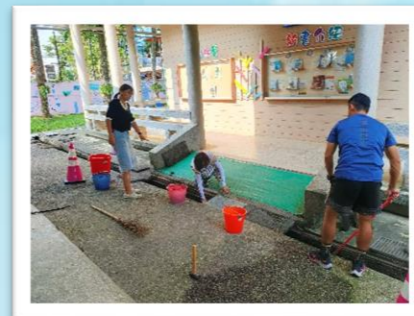
高程設計不良導致水溝污水淤積，無法順利排水，孳生蚊蠅
