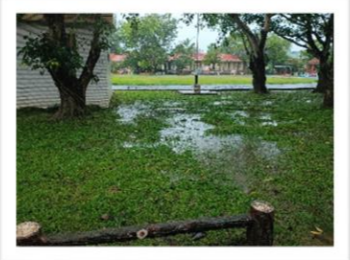
遇強降雨，排水不良易產生積水
