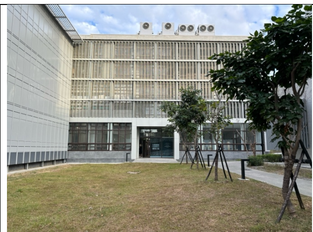
勝利校區未來館東西向遮陽版建置
