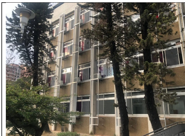
勝利校區勝三舍加裝金屬隔柵網
