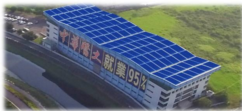
圖2 體育二館之太陽能發電屋頂
