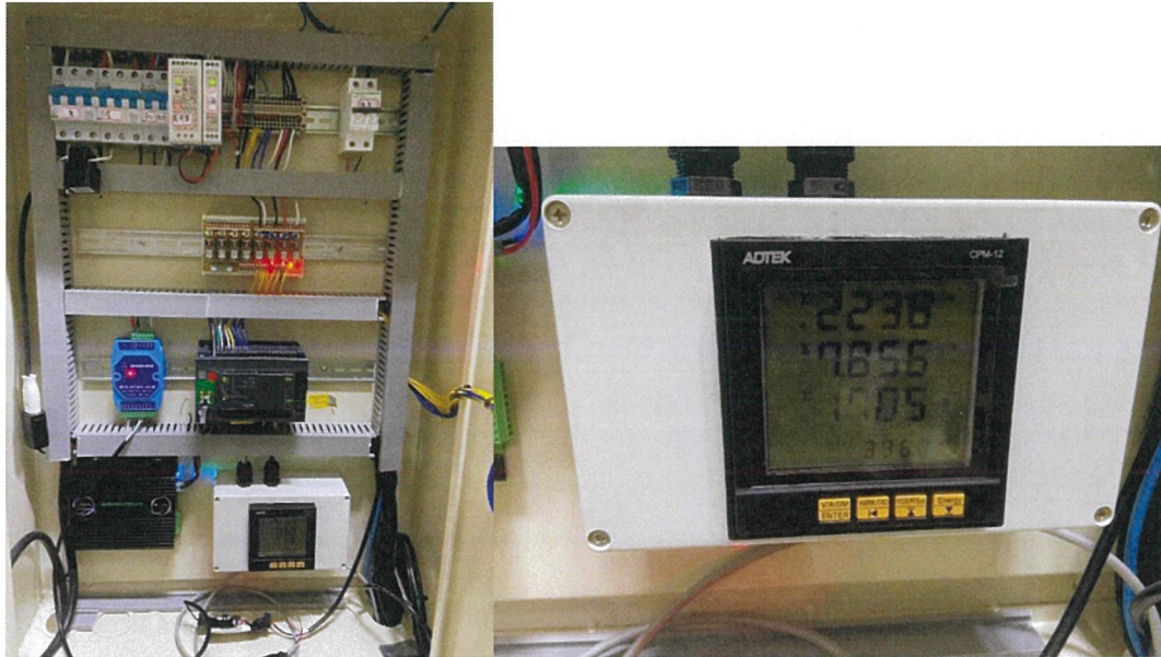
圖 20、電箱內(左)及電錶(右)示意圖
