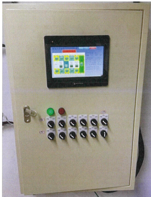
圖 23、HMI 及開關箱示意圖
