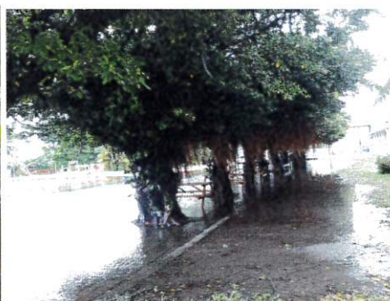
榕樹樹根已造成跑道北面的連鎖磚鋪面隆起，造成地面不平
