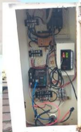
現場安裝控制器與網路
