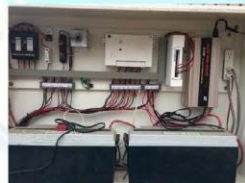
安裝電池與發電裝置
