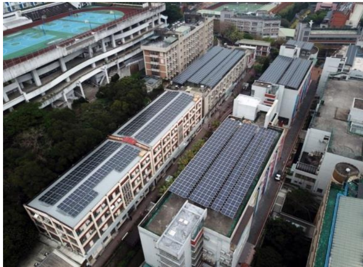
圖：本校473 kW太陽能發電場，年發電量可達50萬度
