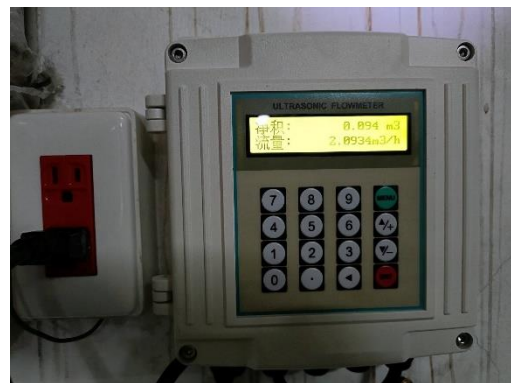
一期地下室設置雨水回收流量計
