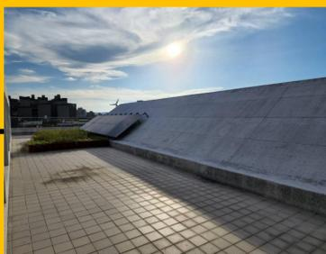
2.新埔樓雨水回收池容量大，可收納912立方公尺，但雨水收集區過小，造成雨水回收效率不佳。
