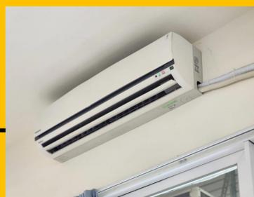
1.本校原有冷氣設備不具有EMS管理系統連結晶片，無法回饋能源使用狀況。
