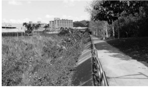
圖 16 渡賢橋下游現況
