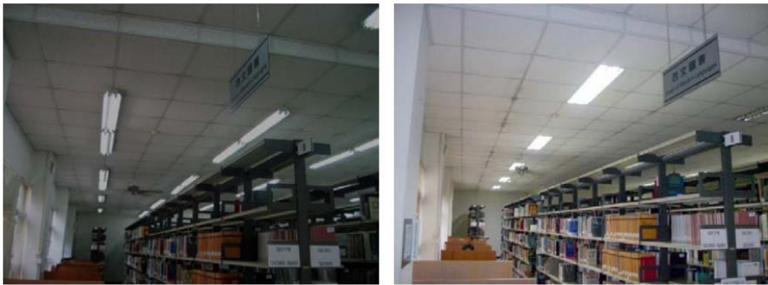
圖 5 依家具設置重新調整燈具配置後改善效果
