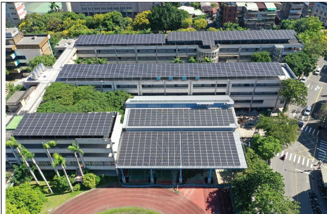
全校區裝設屋頂太陽能板，包括畫面下方之半戶外球場。
