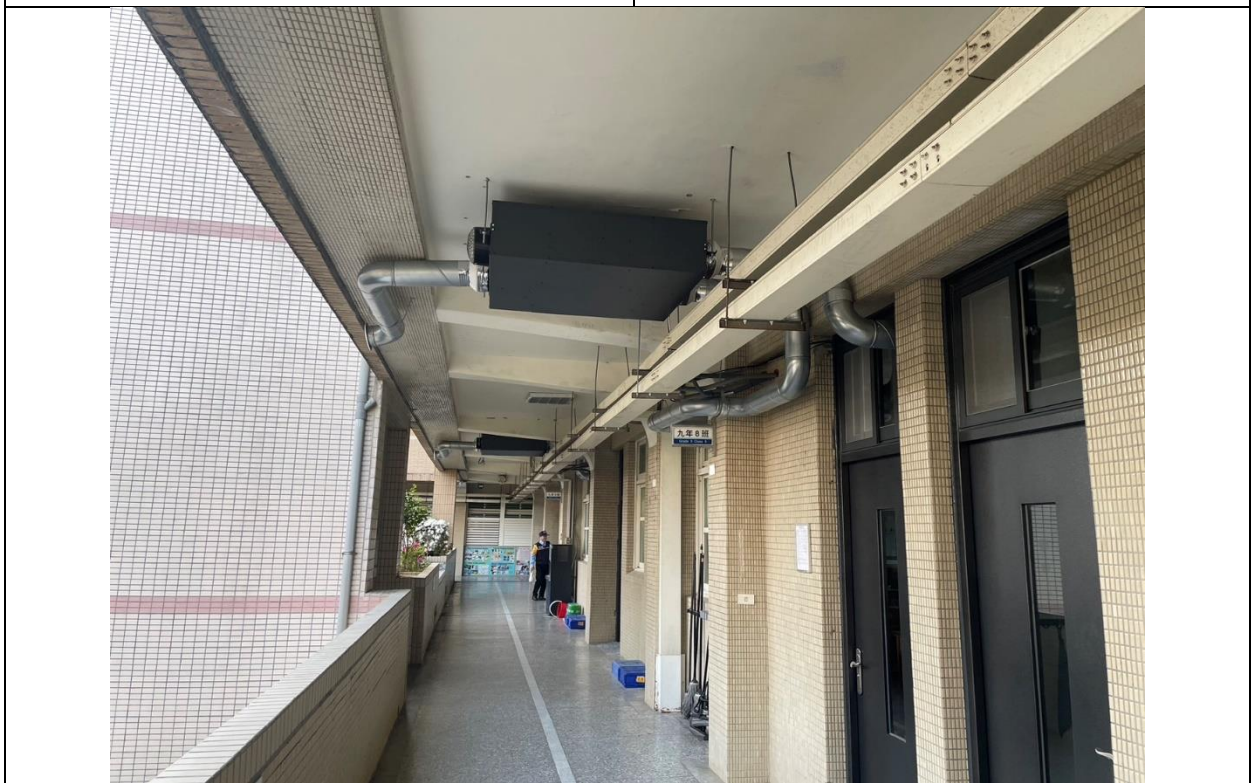
活動名稱：新風系統施工後
