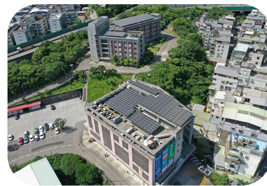
替代能源-屋頂設置太陽能板
