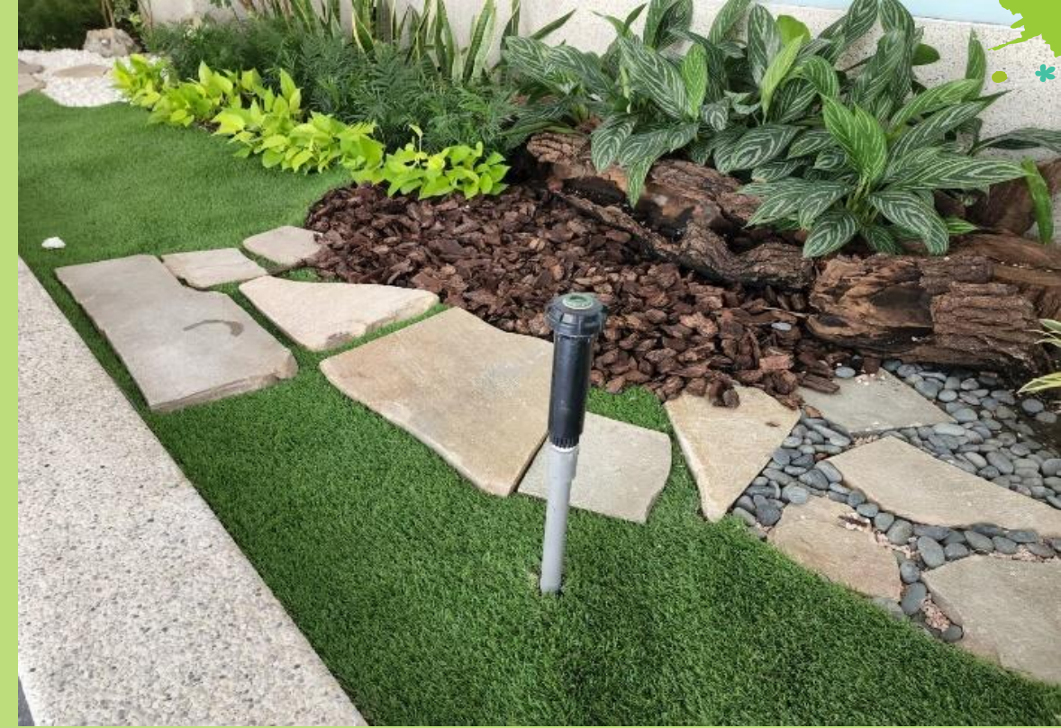
澆灌系統皆使用雨水回收
