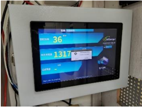
設置電力管理系統，掌握學校用電狀況
