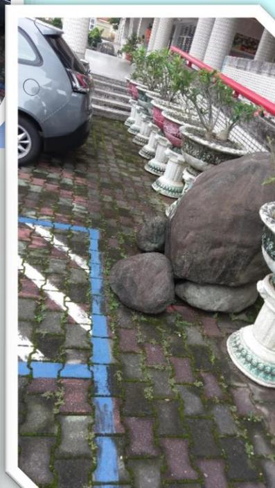
汽車停放區連鎖磚-西曬造成高溫，教學樓熱風效應，改為植草磚解決高溫影響四周微氣候，同時改善青苔溼滑現象，預計可降低鋪面溫度。
