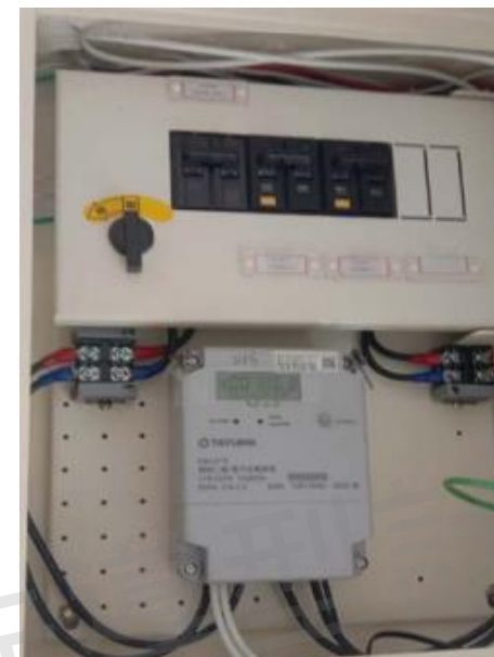
圖片來源：永續校園全球資訊網-歷年成果資料(青潭國小教室裝設數位電錶)
