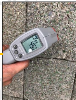
建築物陰影-外側(室外) 2020/07/08 下午2點20分 儀器顯示45.8度
