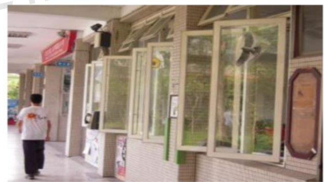
窗戶裝設外推式，能有效將平行外牆風，導流引入室內，調節室內溫度。
