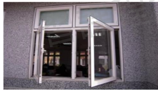
窗戶裝設外推式，能有效將平行外牆風，導流引入室內，調節室內溫度。
