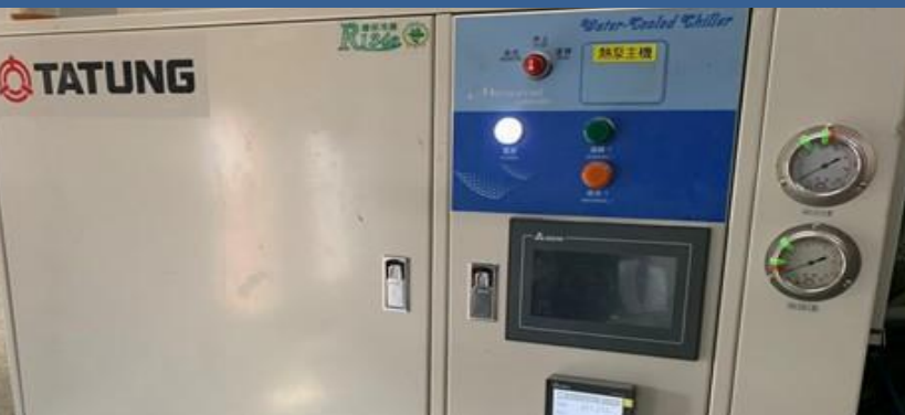
第三宿舍老舊冰水主機汰換高效率冰水主機
