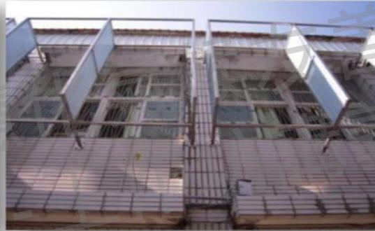
窗戶外架設沖孔遮陽板，阻絕陽光，亦有效達到通風散熱效果。
