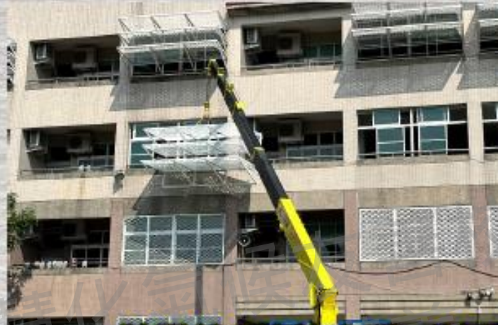
勤學樓3樓的水平式遮陽百葉安裝完成，有效阻隔強光進入，讓班級教室不再長時間拉下捲簾。
